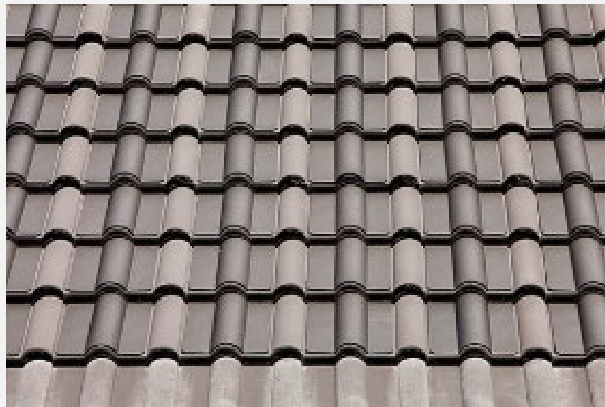
Strecha urobená zo strešných solárnych kolektorov
